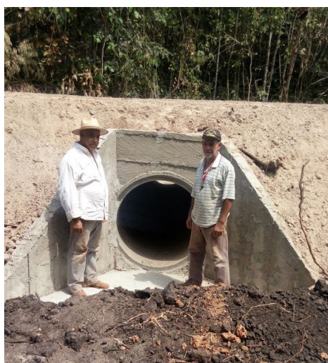
BUEIRO NA VICINAL ENTRE DIST. DE PRIMAVERA E LUIZINHO
