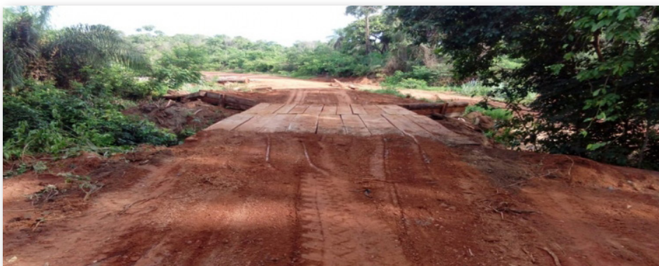
PONTE SOBRE O RIO TAPIRAPÉ P.A. CANABRAVA
