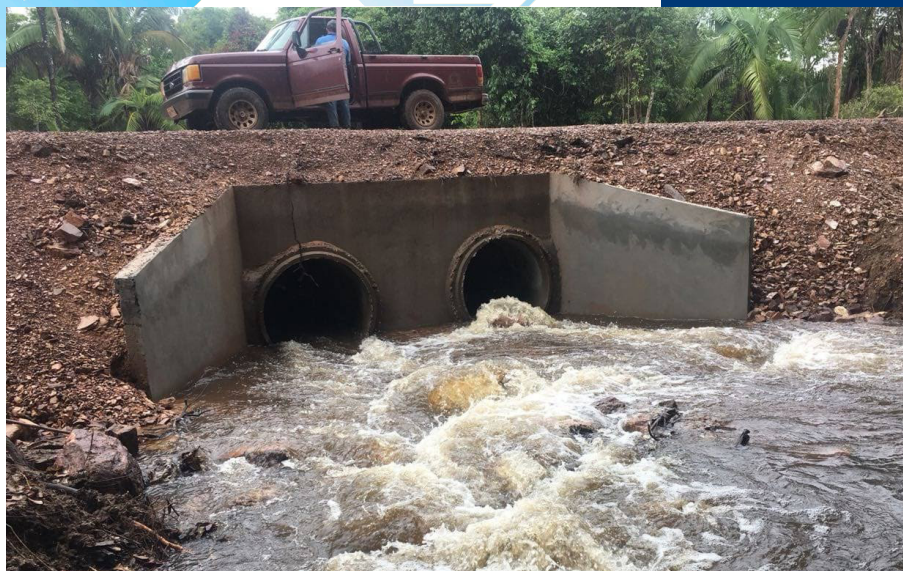
BUEIRO NA ZONA RURAL DE CANABRAVA DO NORTE
