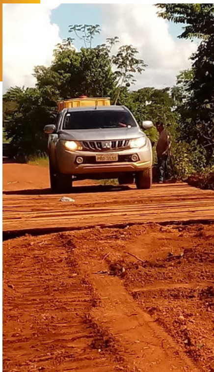
PONTE SOBRE O CÓRREGO MACUCO
