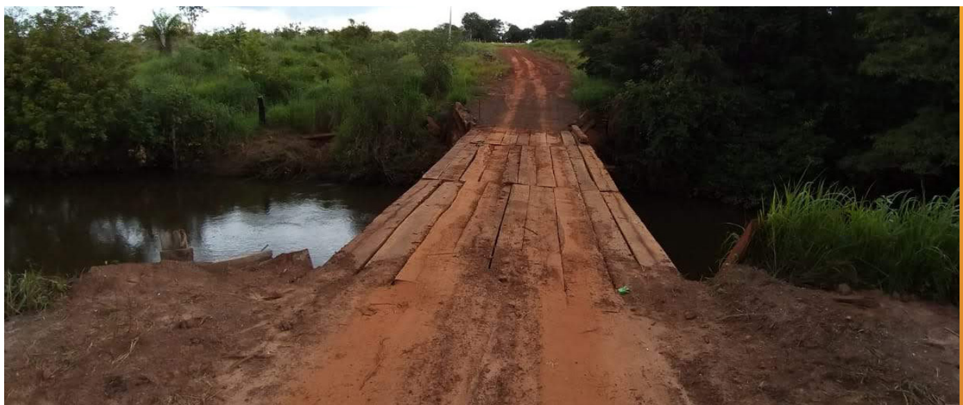
PONTE SOBRE O RIO XAVANTINHO
