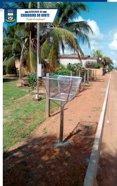
INSTALAÇÃO DE LIXEIRAS INOX EM VÁRIOS BAIRROS
