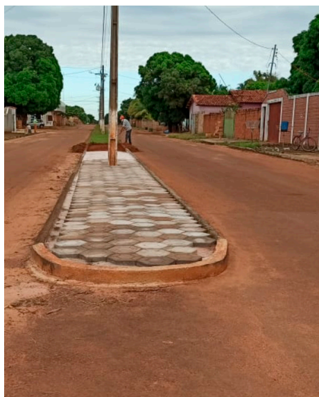
CONSTRUÇÃO E CALÇAMENTO DE MEIO-FIO NA AV. ANTÔNIO BOSAIPO
